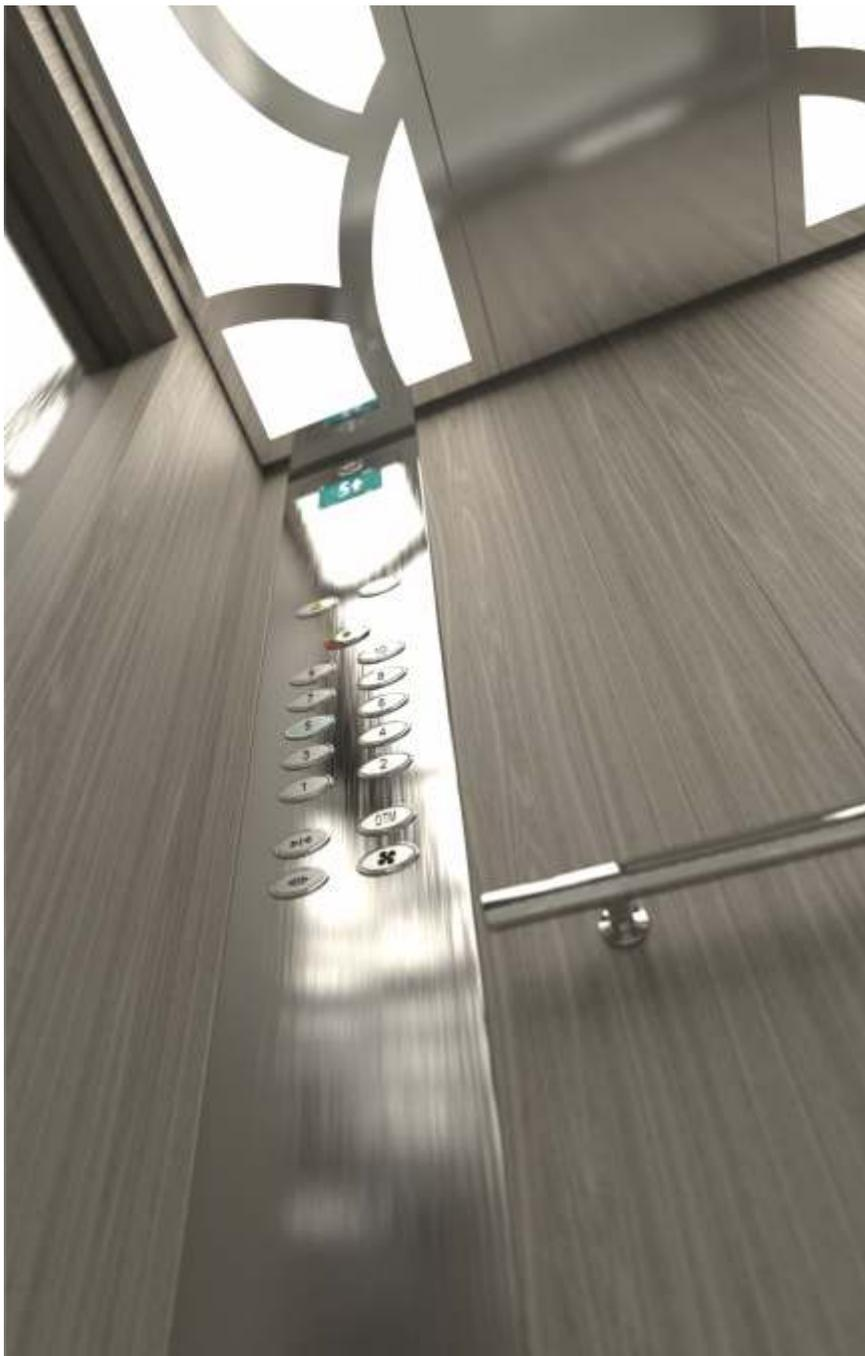
Пассажирские лифты выпускаются грузоподъемностью 225, 300, 320, 400, 630, 1000 и 1275 кг со скоростью движения 2 м/с включительно.
